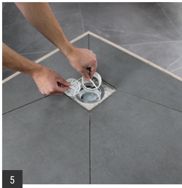
5 Het waterslot beschikt ook over een haarnetje. Haal deze uit het waterslot en reinig deze met water.
